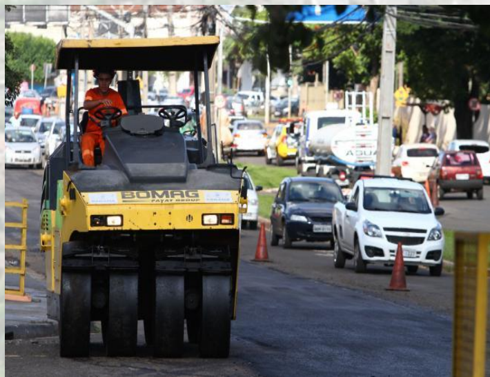
Recapeamento e sinalização na Av. Tiradentes
