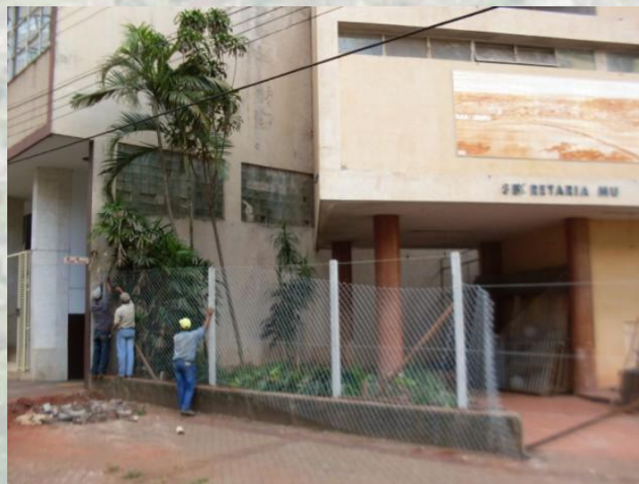
Restauro do Prédio da Sede da Secretaria Municipal de Cultura
