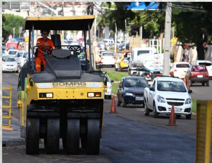
Recapeamento e sinalização na Av. Tiradentes
