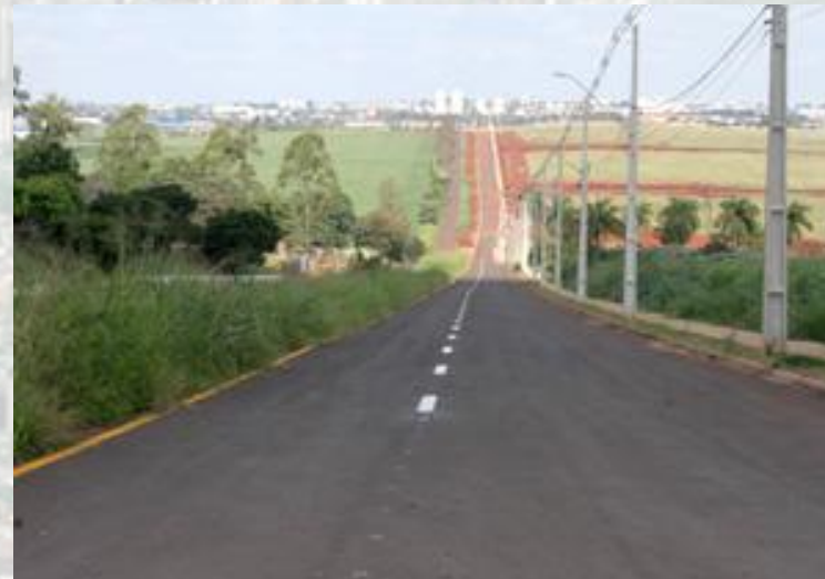
Duplicação da Avenida Angelina Ricci Vezozzo
