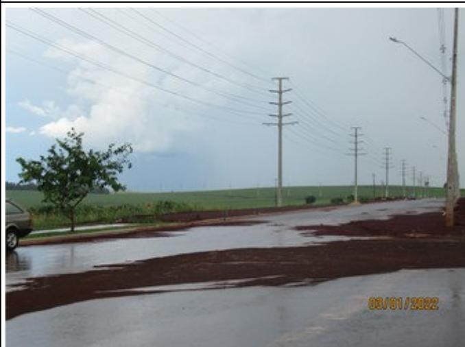
**Figura 01** – Problemas com deslizamento de solo sobre a Av. 01A.
