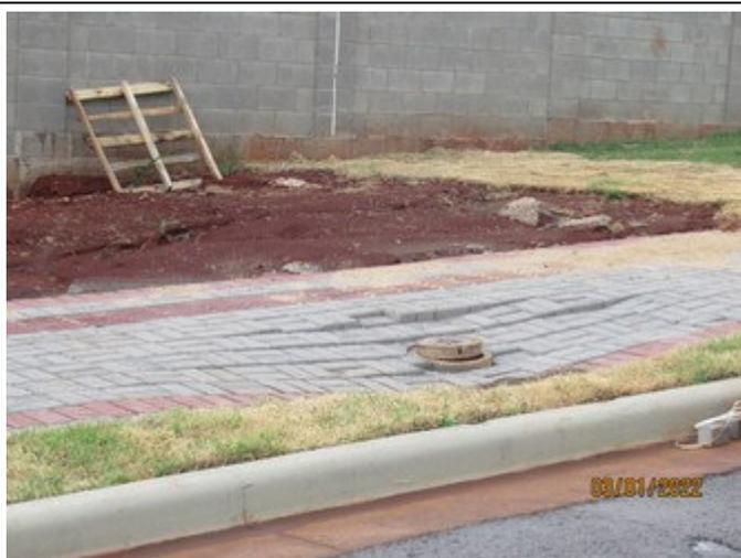
**Figura 04** – Recalque de solo em calçada na Av. Pioneiros.
