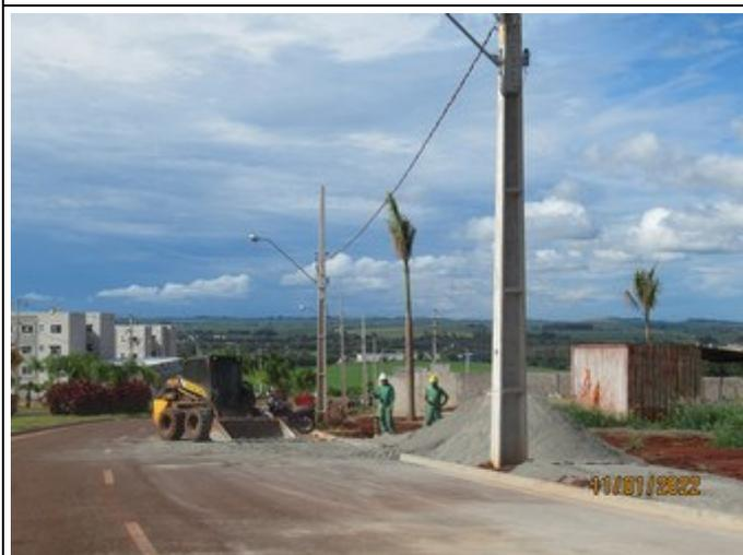
**Figura 11** – Execução de calçada na Av. 02B.
