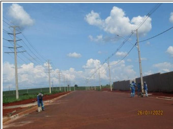
**Figura 19** – Execução de bocas de lobo na Av. 01A.
