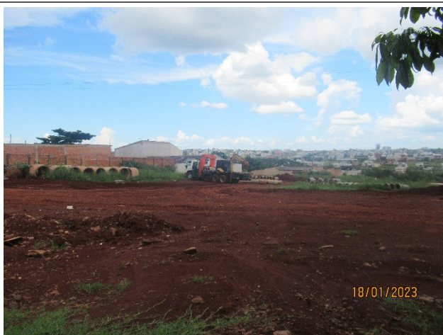
Figura 3 – Descarregando equipamentos para retomada dos serviços.
