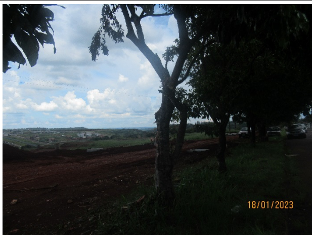
Figura 1 – Sanepar realizando a duplicação da rede adutora no espigão do loteamento.
