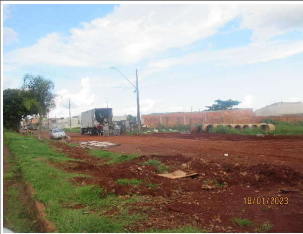
Figura 2 – Descarregando equipamentos para retomada dos serviços.
