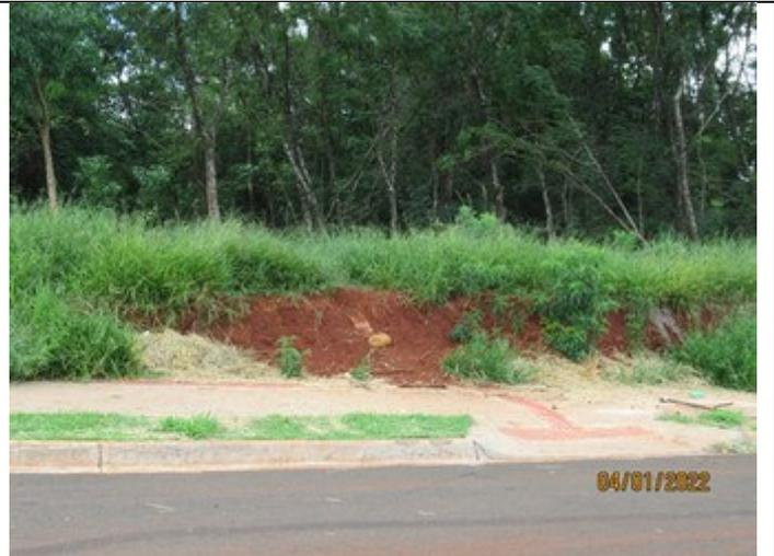
**Figura 4** – Necessário executar muretas nos lotes com inclinação superior a 5%.
