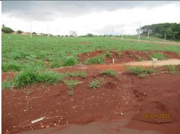
**Figura 9** – A falta de muretas esta gerando deslizamento de terra devido a inclinação dos terrenos.
