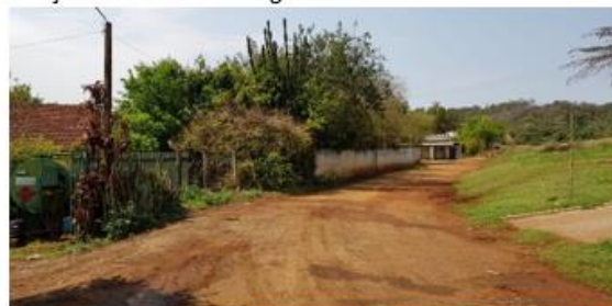
Vias de acesso – sem pavimentação
