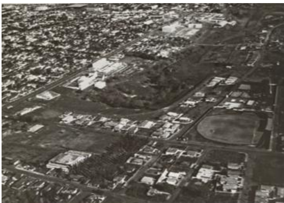
Figura 14. Fundo de Vale do córrego Água Fresca – 1971. Fonte: Bortolotti, 2007.
