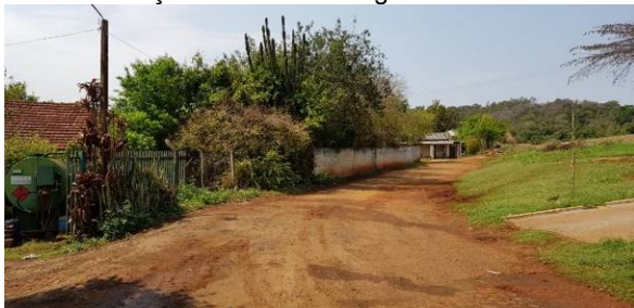
Vias de acesso – sem pavimentação
