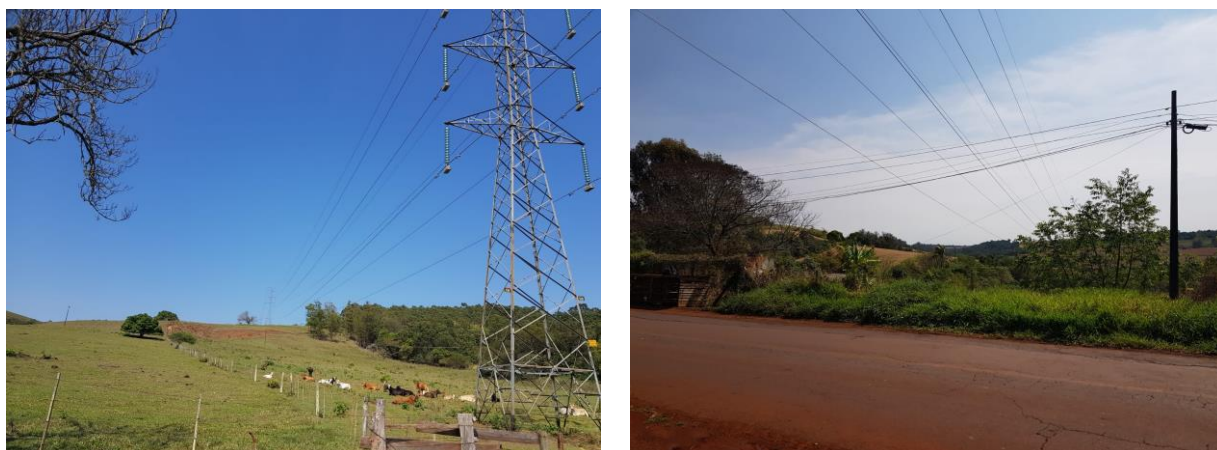
Figura 31 – Linha de transmissão de energia na AEU-DS
