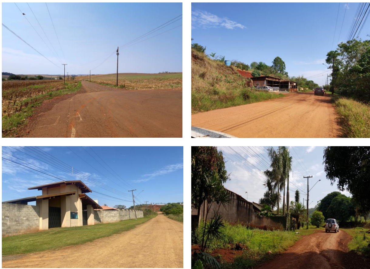
Figura 28 – Imagens relacionadas a iluminação pública e estruturas elétricas na AEU-DS
