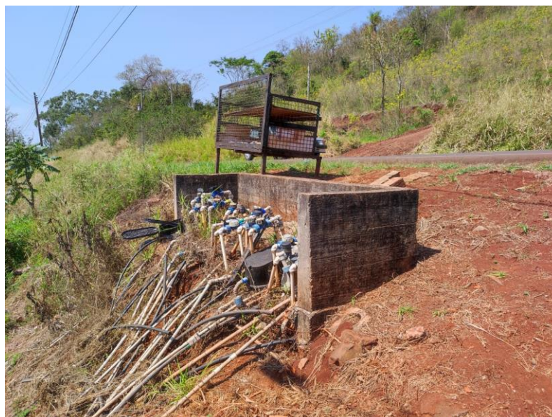
Figura 25 – Imagem obtida na localidade relacionada ao abastecimento público de água
