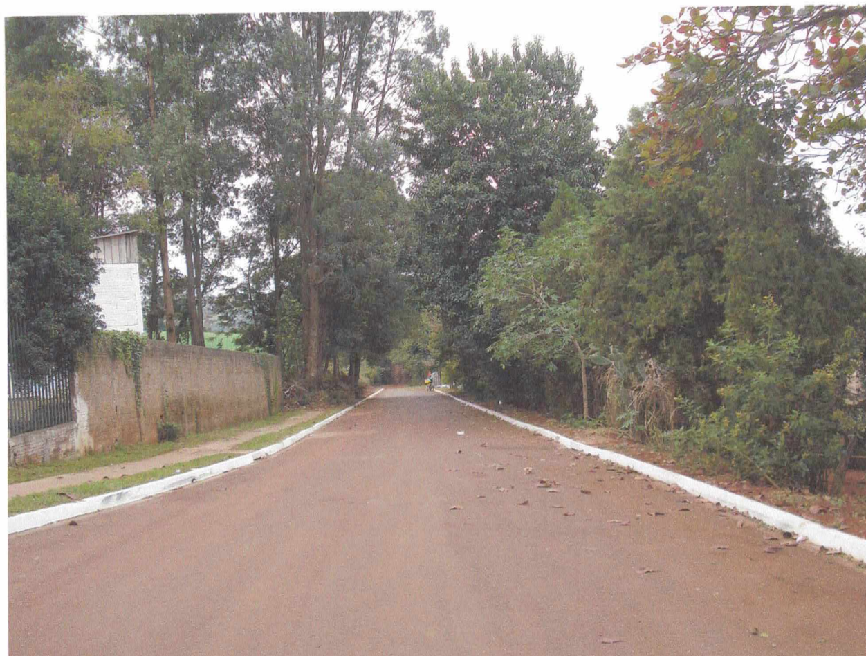
Foto 07: acesso pavimentado, divisa leste do lote 59 – Ac05
