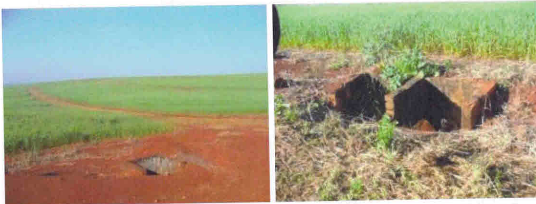
Figura 24: Exemplos de bocas de lobos encontradas na área objeto da mudança de zoneamento.
