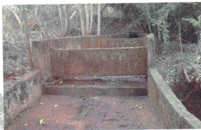
Figura 31: Vista do dissipador no Córrego Gabiroba (Julho de 2010).
