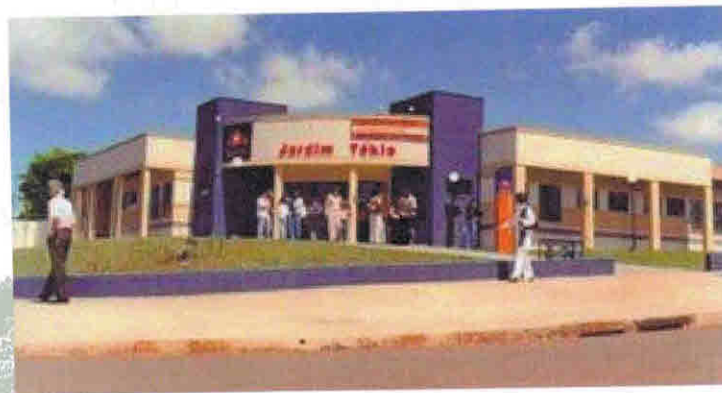
Figura 22: Centro de Saúde Municipal Carlos Augusto Mungo Genez – UBS Jardim Tóquio, que atende ao Portal de Versalhes 3.
