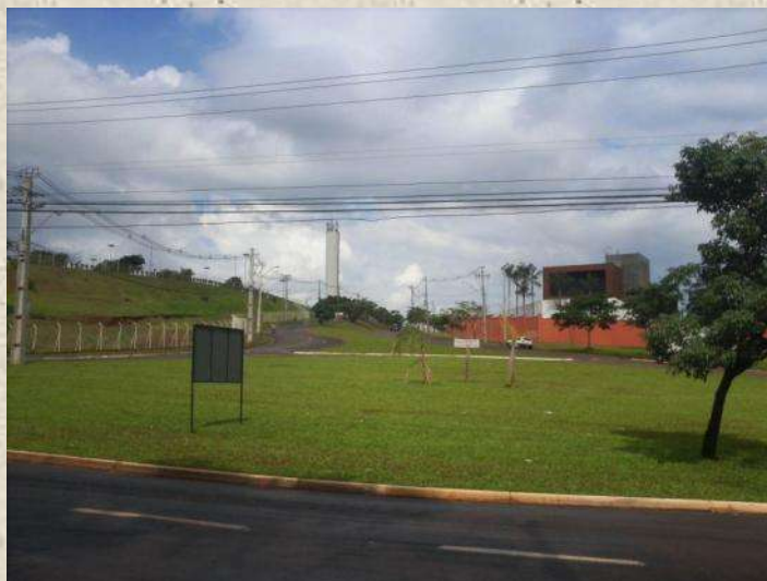
Figura 23: Rotatória ao Norte – Rodovia Mábio G. Palhano x Avenida Terras de Santana – Ponto 01 da contagem.
