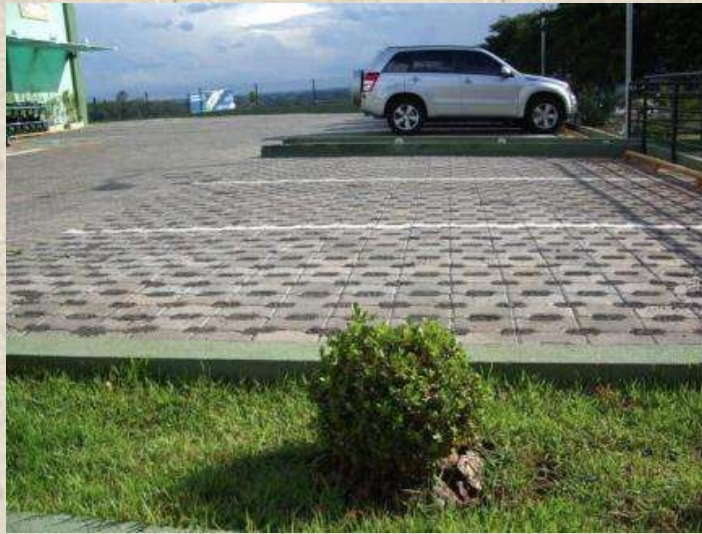
Figura 34: Pavimentação permeável: jardins, concregrama e blocos intertravados.
