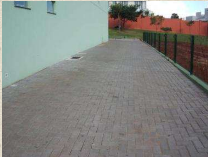
Figura 36: Blocos intertravados implantado.
