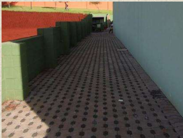
Figura 35: Concregrama implantado, preenchido com brita basáltica.
