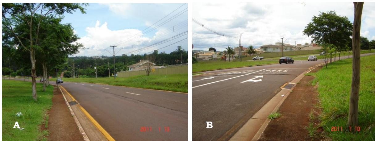
Figura 11: Pavimentação do local.
