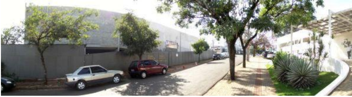
Vista obra - Rua:Antonio Amado Noivo
