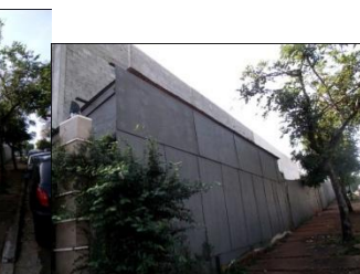
Vista Obra Rua:Antonio Amado Noivo
