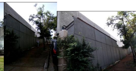
Vista obra Rua: Antonio Amado Noivo
