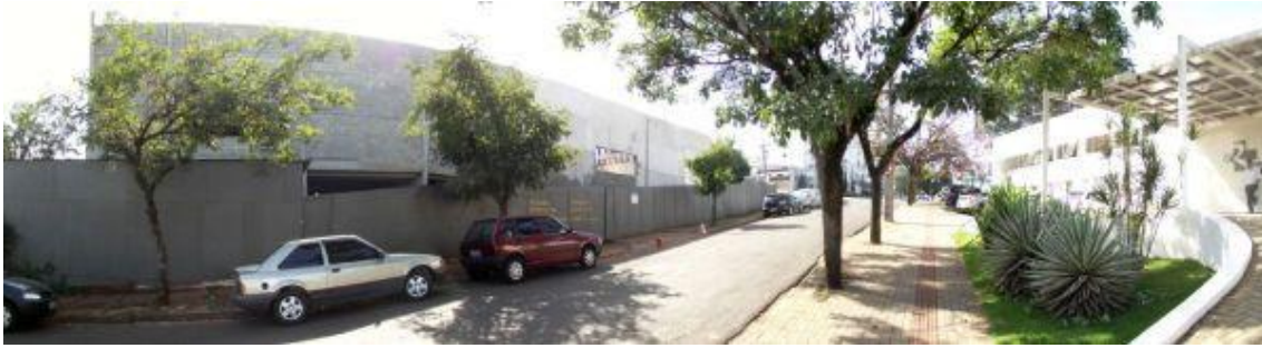
Vista Obra Rua:Antonio Amado Noivo
