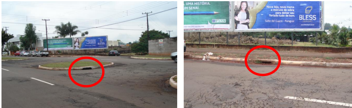
Figura 20: Bocas de lobo localizadas na Avenida Adhemar Pereira de Barros, próximo ao empreendimento proposto.
