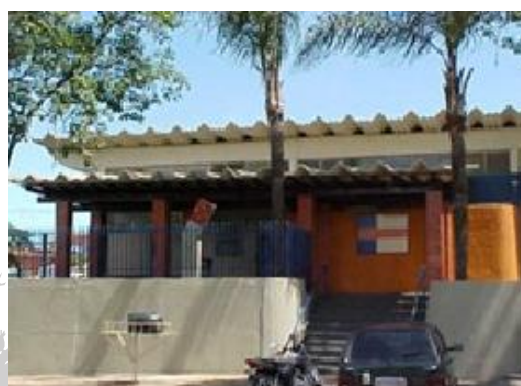
Figura 17: Centro de Saúde Municipal Dr. Ibrahim Soubhia, que atende ao entorno do empreendimento.
