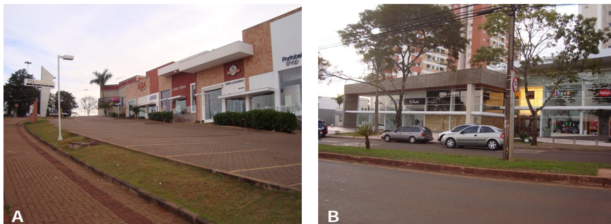
Figura 14: Vista geral de centros comerciais localizados na Av. madre Leônia Milito.
