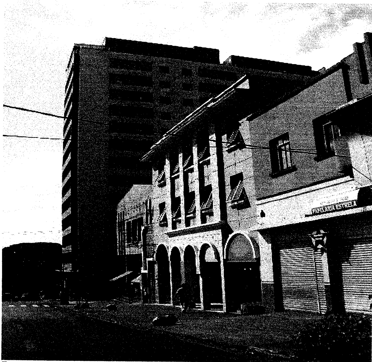
Foto 10: Uso do entorno do lote: Av. Rio de Janeiro.
