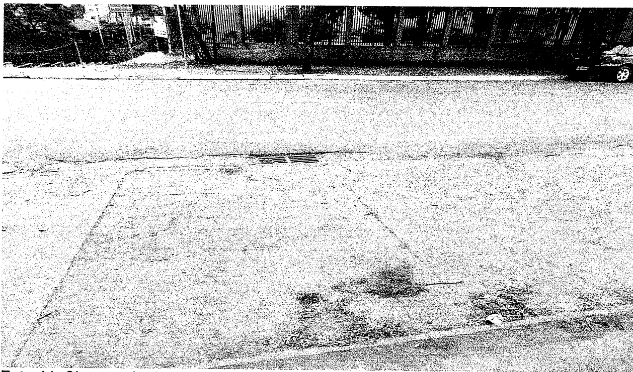
Foto 11: Sistema de drenagem pública em frente ao lote em estudo.
