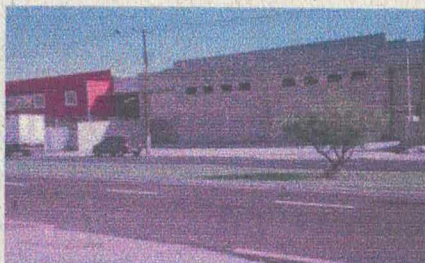
(FOTO 06) - Edificação da Frente
