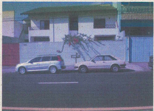
(FOTO 17) - Edificação da Esquerda
