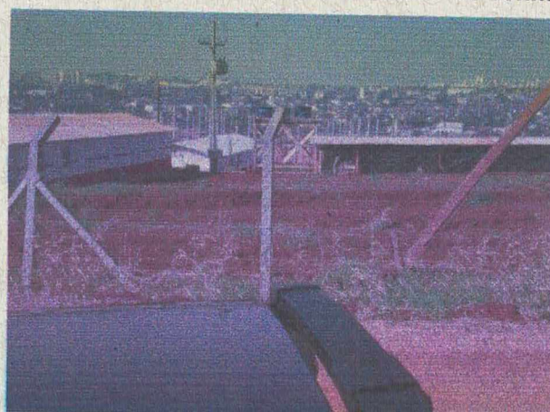
(FOTO 14) – Estágio atual da obra do Shopping.
