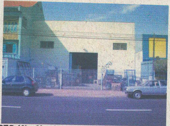
(FOTO 19) - Metalurgica á direita - 2º Edificação
