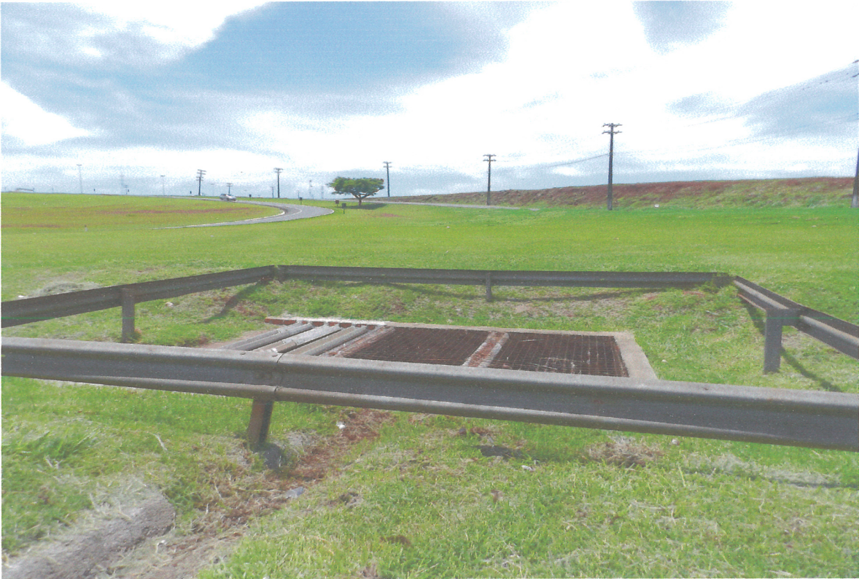
Foto 07: Caixa de captação de águas pluviais em frente ao terreno.
