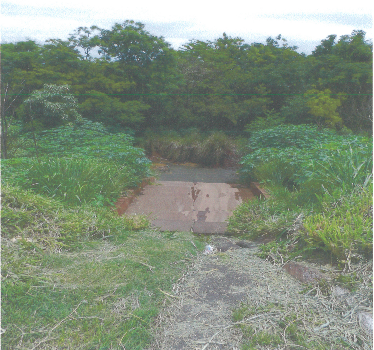
Foto 10: Dissipador da galeria de águas pluviais.
