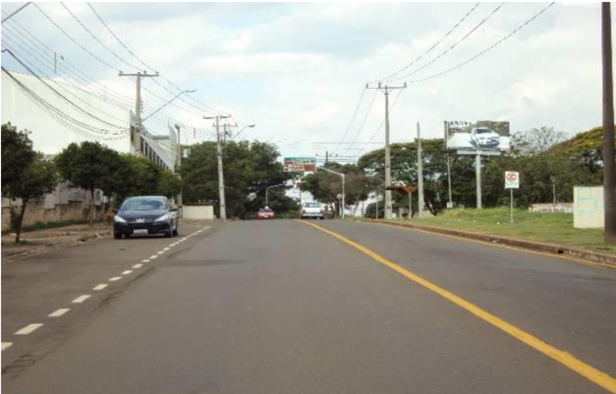
Foto 20: Baía de desaceleração – acesso ao lote – Av. Pref. Faria Lima.
