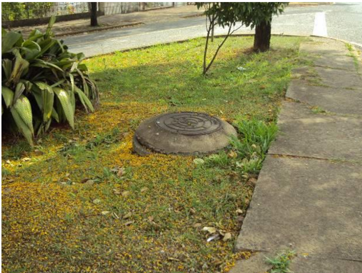
Foto 12: Rede de esgoto – Av. Pref. Faria Lima - em frente ao lote em estudo.
