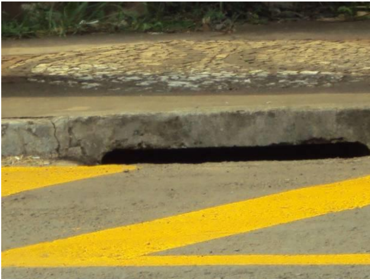
Foto 13: Boca de Leão - drenagem urbana - Av. Faria Lima - em frente ao lote.
