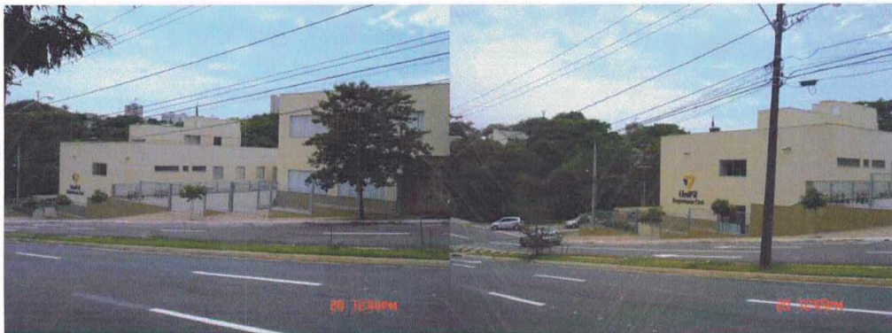
Fotos: Dept. Engenharia Civil – Rua Goiás x Rua do Escoteiro.
