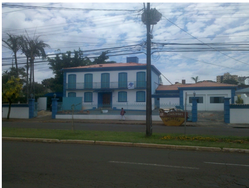
Figura 02: Vista frontal do terreno.
