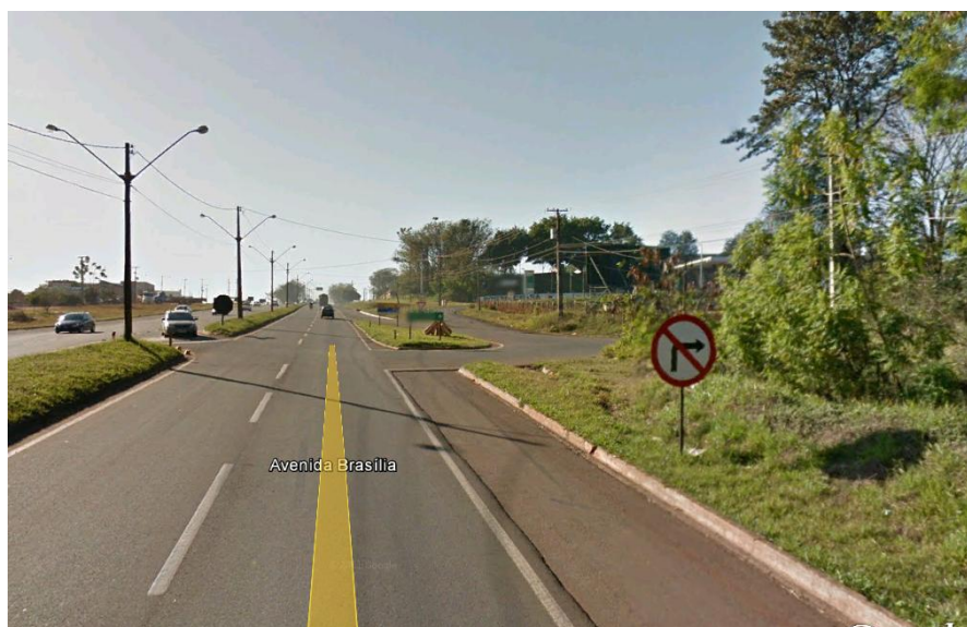
Figura 37: Sinalização vertical de conversão proibida.
