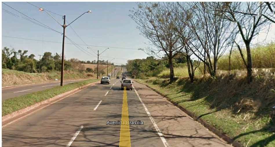
Figura 32: Sinalização vertical da Avenida Brasília – sentido Ibiporã – Londrina;
