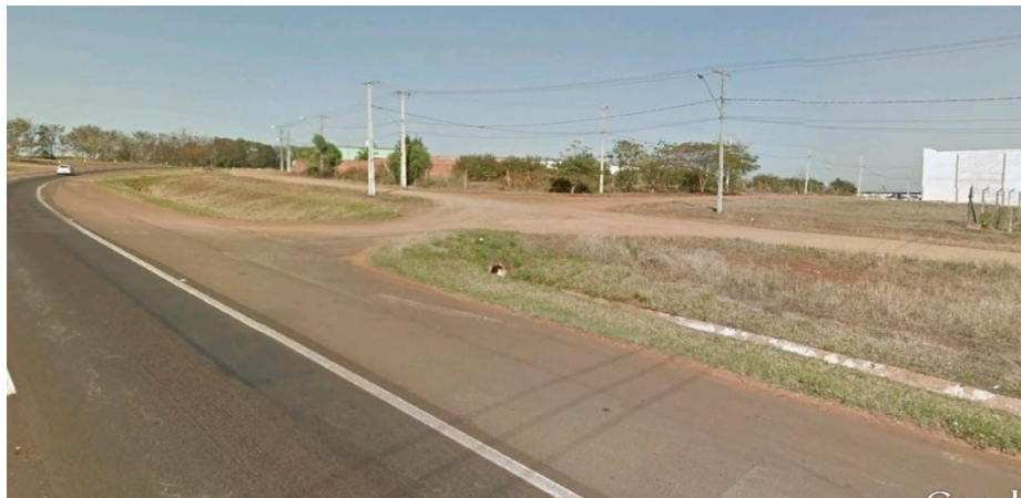
Figura 51: Acesso da Estrada do Contorno Norte para a Rua Alfieri Faé.
