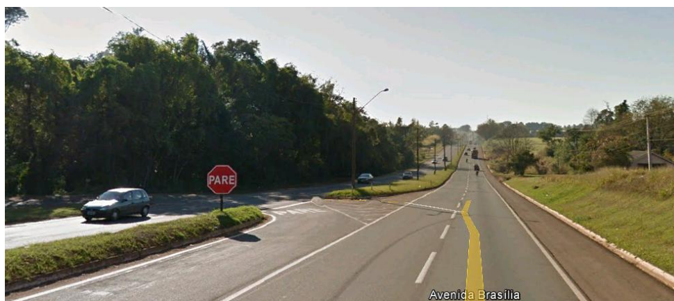
Figura 36: Sinalização vertical e horizontal do retorno existe.
