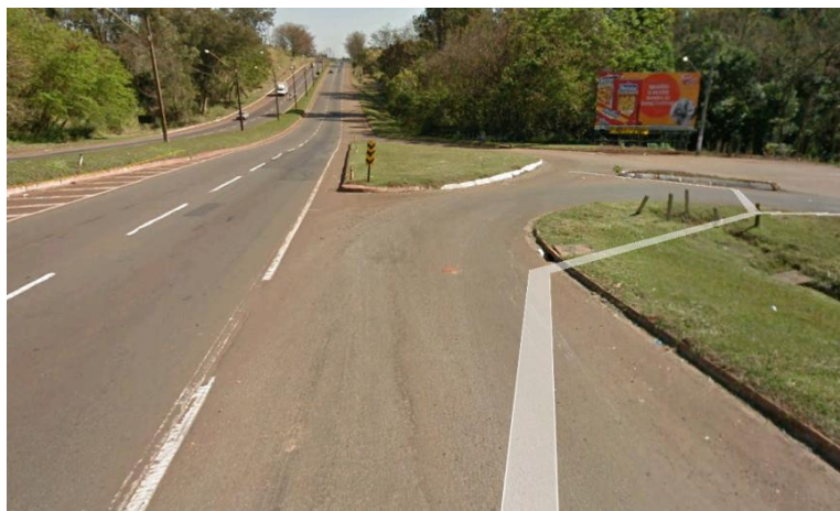
Figura 49: Acesso da Avenida Brasília (BR 369), para a Rua Walter Bussadori.
