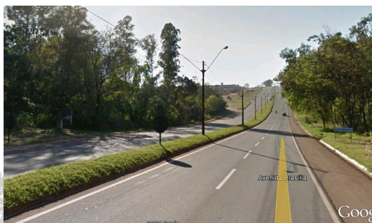
Figura 34: Avenida Brasília – sentido Londrina – Ibiporã e sua sinalização horizontal de faixa de rolamento.
