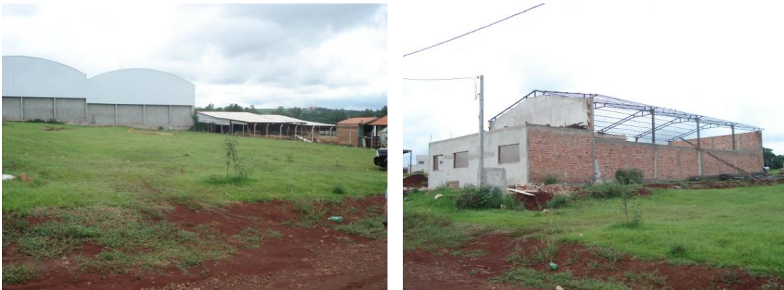
Figura 09: Lote sem ocupação e obras em execução no entorno do local objeto desse estudo.
