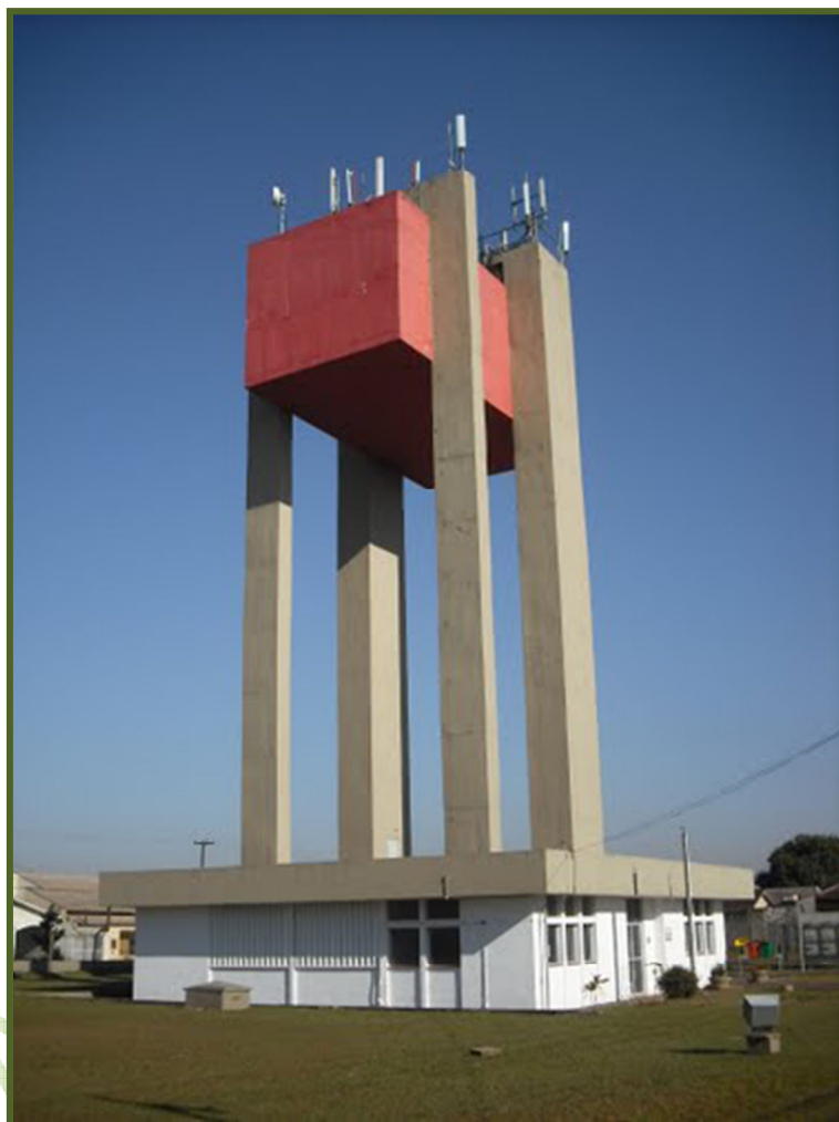
IMAGEM 04 – RESERVATÓRIO SANEPAR COM ROOF TOP TIM.
