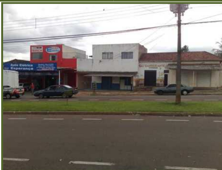
Fonte: Telemont Engenharia de Telecomunicações S/A.
