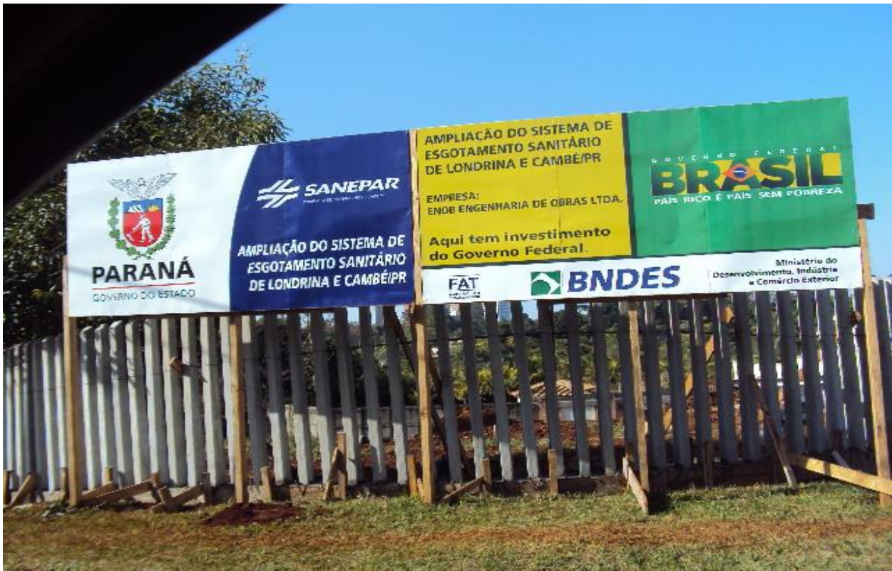
Foto 13: Obras da E.E.E. na Av. Adhemar Pereira de Barros.
