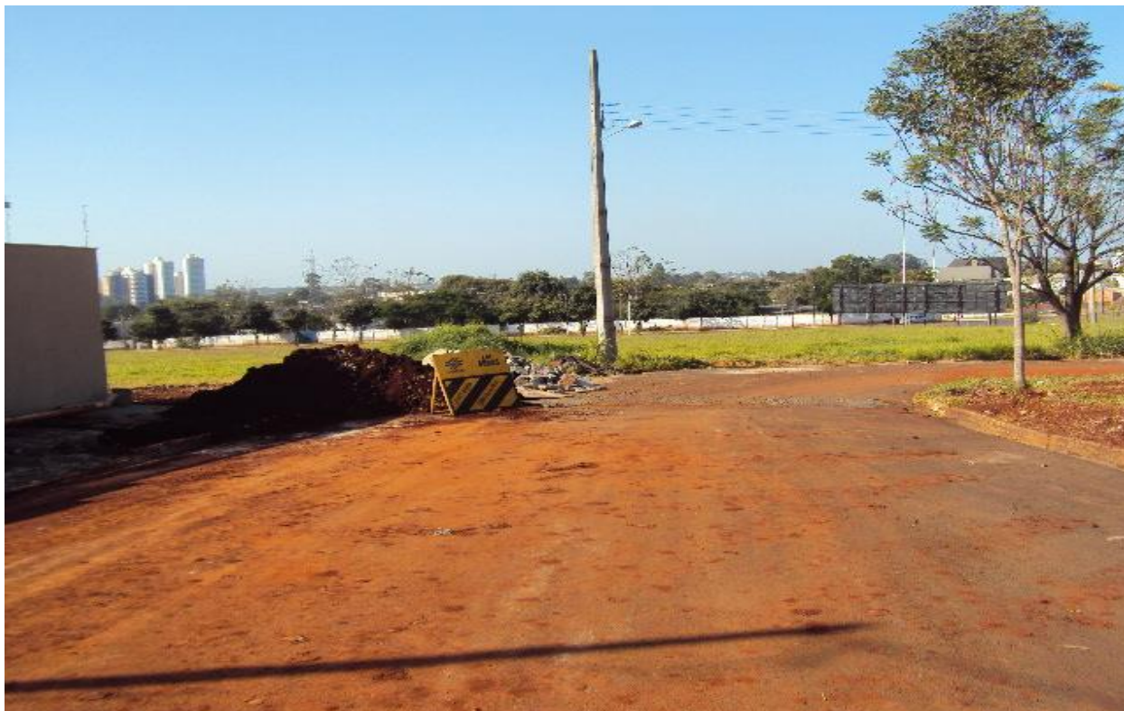
Foto 12: Obras de rede de esgotamento sanitário Rua José N. Franco.
