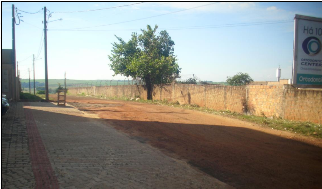
Figura 18: Inexistência de pavimentação asfáltica na Rua Constantino Paschoal. Fotos: Brasil Ambiental, 2012.
