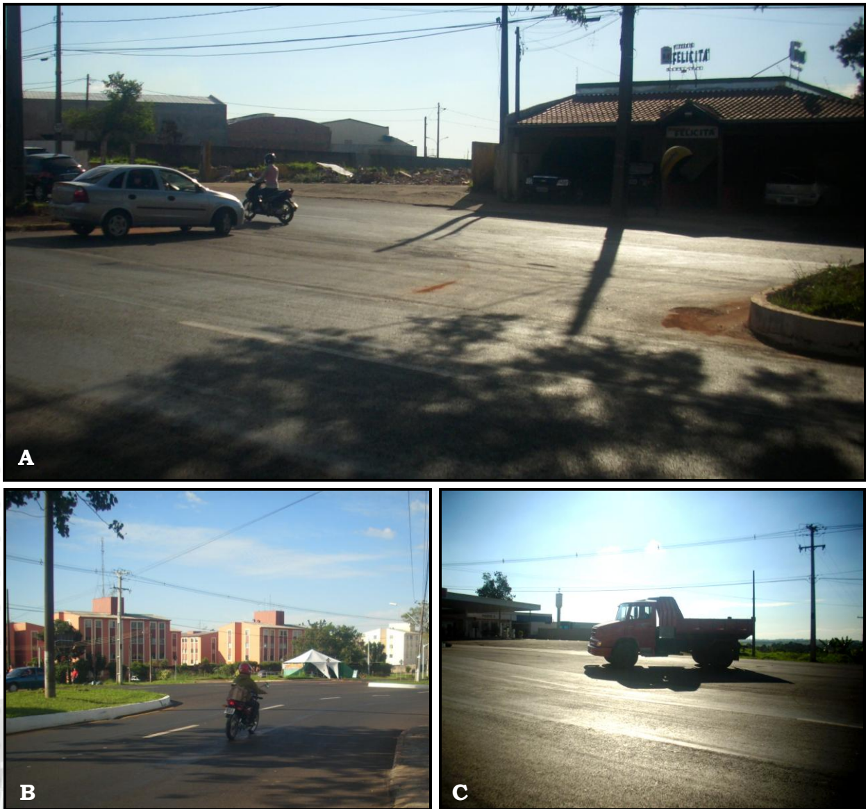
Figura 12: Ausência de sinalização horizontal e de placas indicativas de movimentação permitida (conversões) em uma das vias de acesso ao empreendimento.
