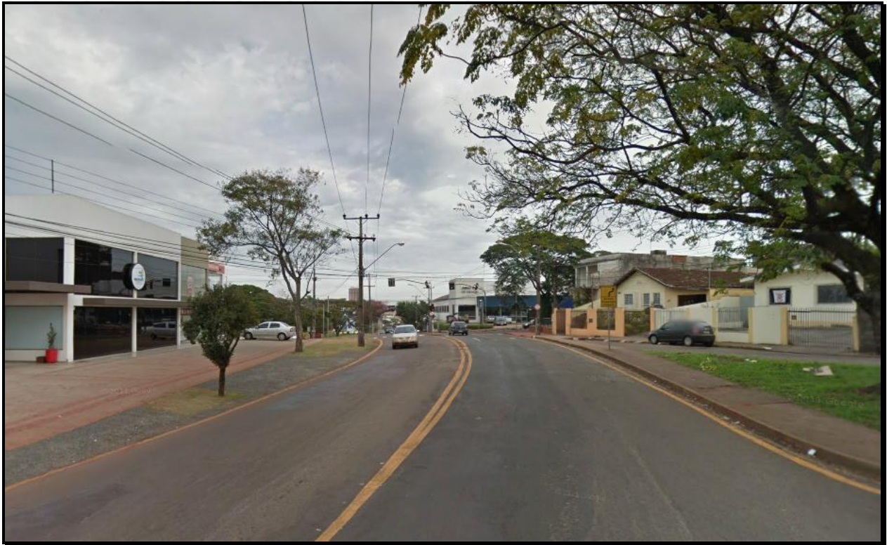
Figura 19: Via estrutural secundária.
