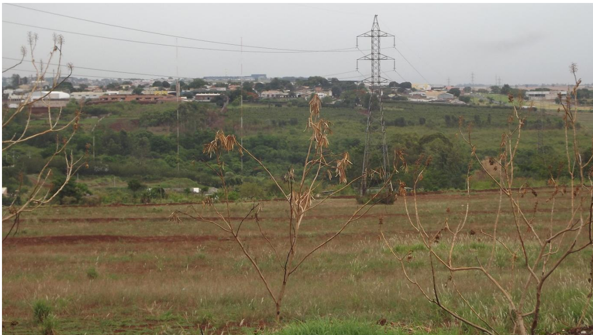
Figura 16. Torre de distribuição de energia elétrica no terreno do empreendimento Fonte: próprio autor.
