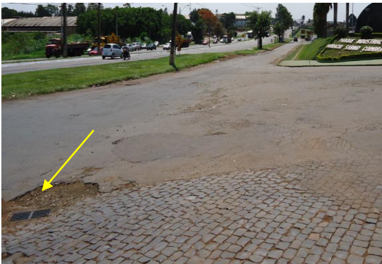
Figura 27: Vista de bueiro instalado nas proximidades do empreendimento.
