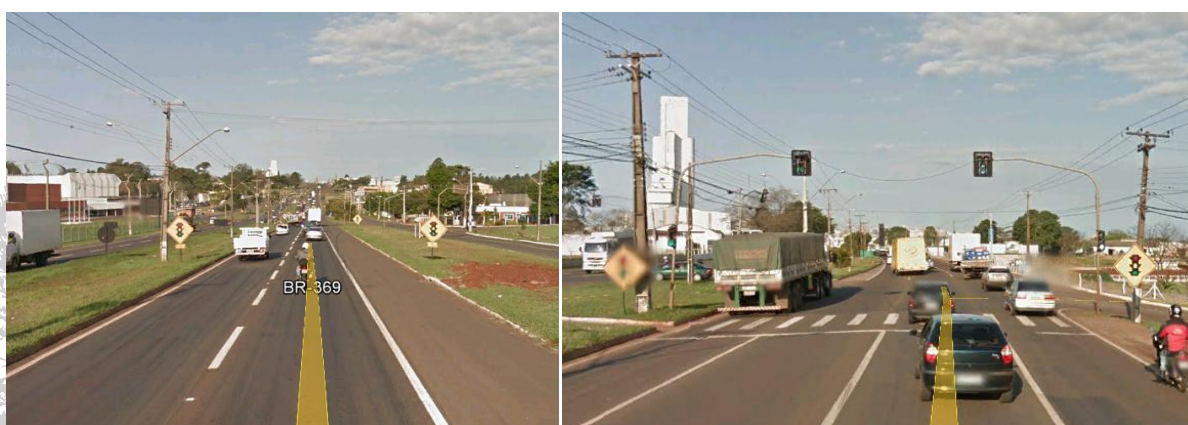
Figura 44: Vista da Avenida Tiradentes (BR 369), sentido Cambé - Londrina, e a variação do número de faixas de rolamento. Fonte: Google Street View (2012).
