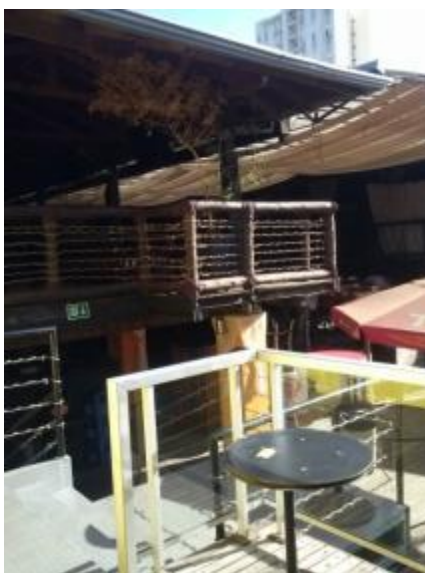
Figura 5: Vista geral da edificação.
