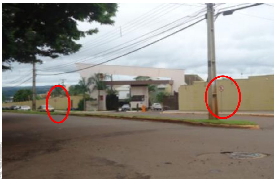
Figura 41: Rua Luiz Lercos e sua sinalização vertical de regulamentação. Fonte: Master Ambiental (2013).
