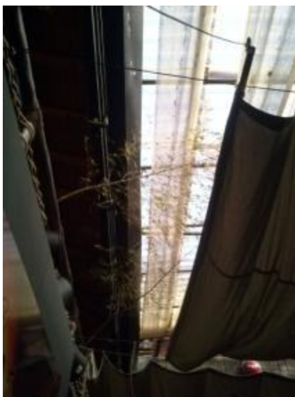
Figura 4: Pátio coberto com telha tanslúcida.
