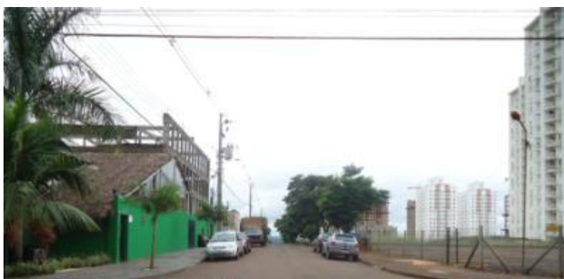
Figura 24: Vista das instalações da iluminação pública na Rua José Roque Salton. Fonte: Master Ambiental (2013).
