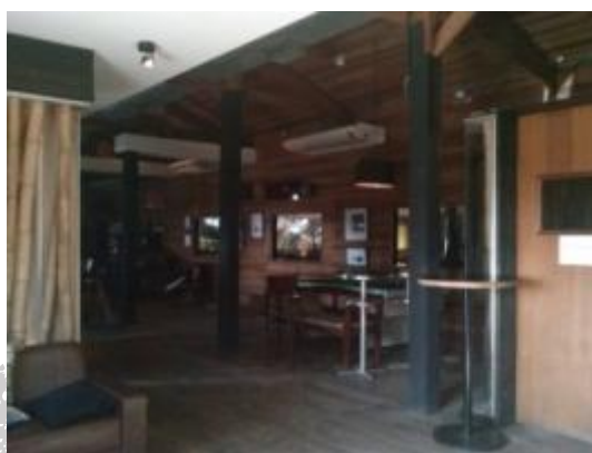
Figura 3: Estrutura em madeira do Mezanino.
