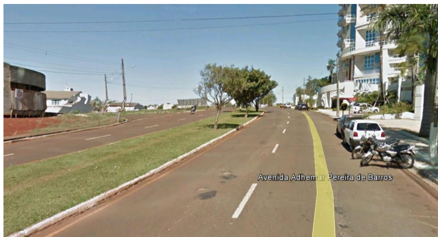
Figura 31: Vista da Avenida Adhemar Pereira de Barros, sua sinalização horizontal e a permanência de veículos estacionados do lado direito da pista. Fonte: Google Street View (2012).
