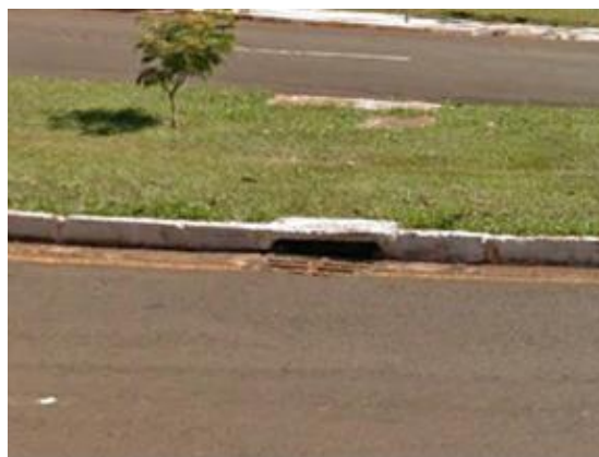
Figura 21: Vista de bueiro instalado na a Avenida Adhemar Pereira de Barros.
