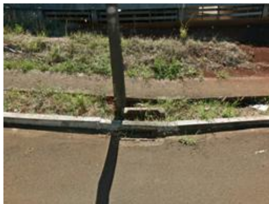
Figura 19: Vista de bueiro instalado na Rua Alberto Maurício Barroso Júnior.
