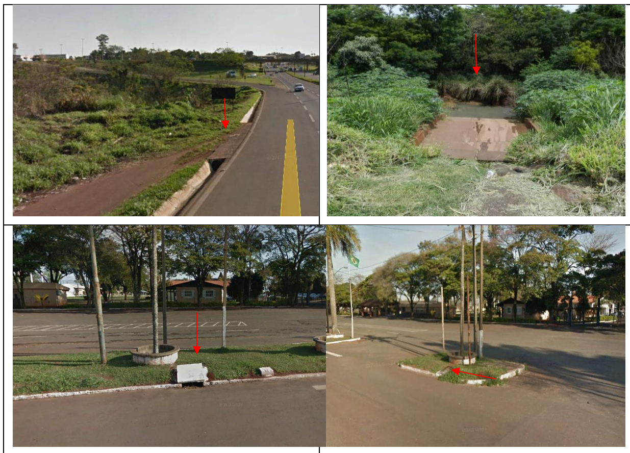
Figura 13: Sistema de drenagem pluvial na área da empresa Ingá Veículos LTDA Fonte: Google Street View
