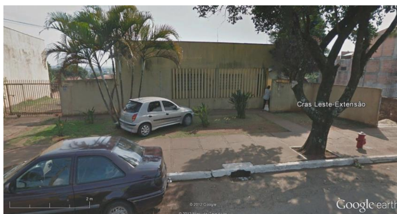
FONTE: Google Earth – Street View FOTO Nº03 – CRAS – Centro Regional de Assistência Social - Leste
