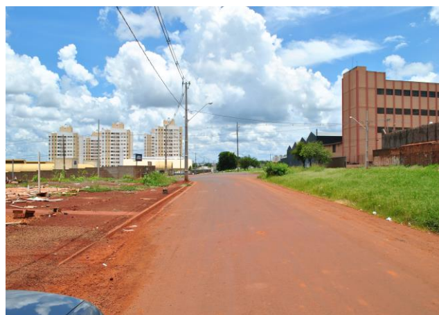
FOTO Nº18– Vista da Rua Atílio Octávio Bizzato para leste
