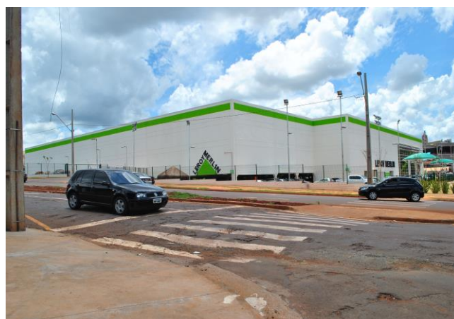
FOTO Nº16– Vista da Loja Leroy Merlin
