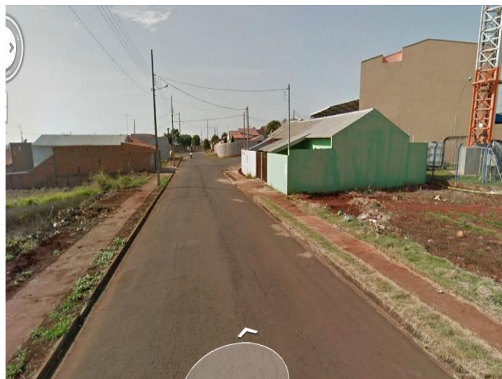
Figura 08 – Vista Av. Paulo José Figueiredo – Asfalto em bom estado de conservação
