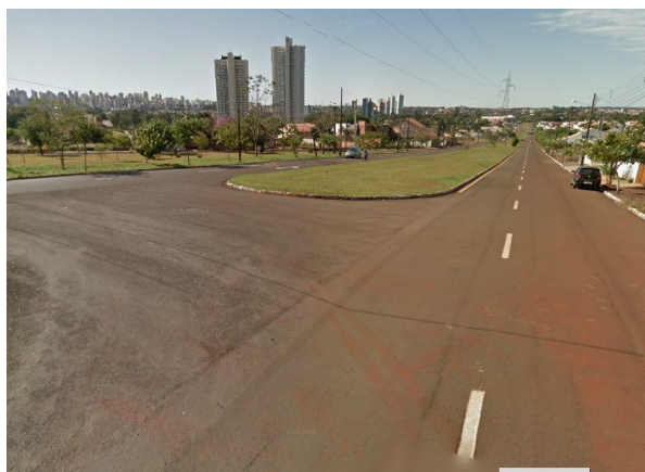
Figura 15. Situação da Av. Waldemar Spranger em frente à Igreja. Fotos: Geopar Ambiental, 2013.
