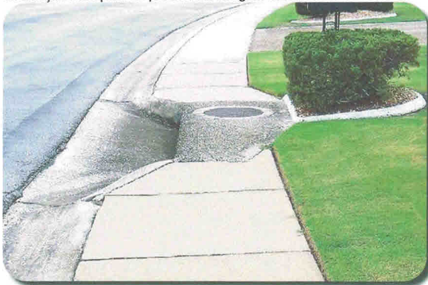
Figura 4.2. Proposta de calçamento que mantém áreas de infiltração, privilegia o escoamento das águas pluviais na galeria e permite a circulação tranquila de pedestres. Imagem meramente ilustrativa.
