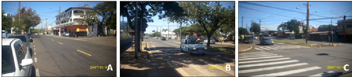
Figura 16: Condições físicas da via principal de acesso ao estabelecimento.
