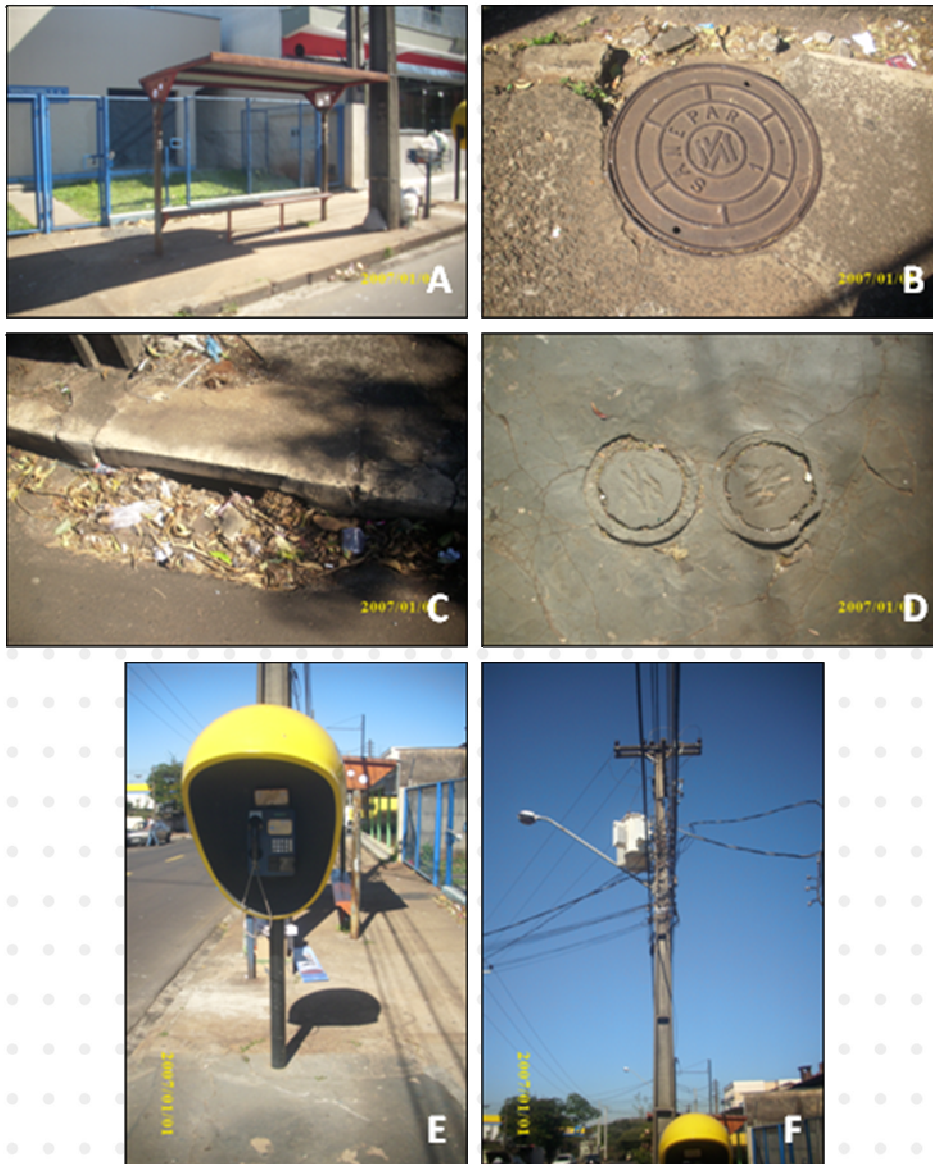
Figura 14: Infraestrutura pública existente na Área de Influência Direta.
