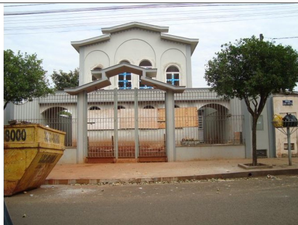
Vista do Templo existente (do leste para o oeste)
