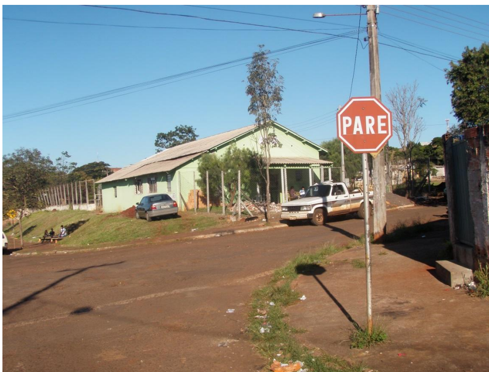
Figura 17: Detalhe das instalações de iluminação pública.
