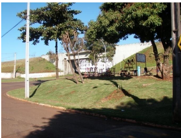
Figura 27. Travessia viária da ferrovia em desnível. Fonte: Master Ambiental, 2013.
