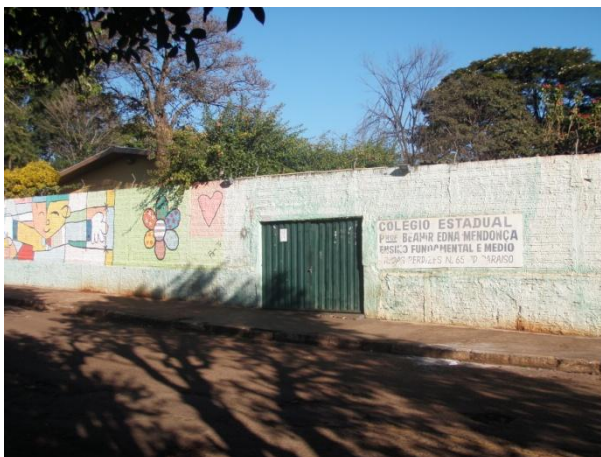
Figura 24. Colégio estadual a leste do CEI. Fonte: Master Ambiental, 2013
