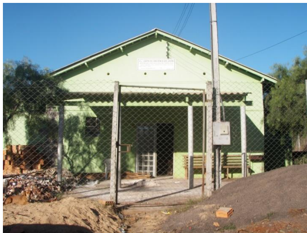
Figura 11: Vista da entrada do empreendimento.
