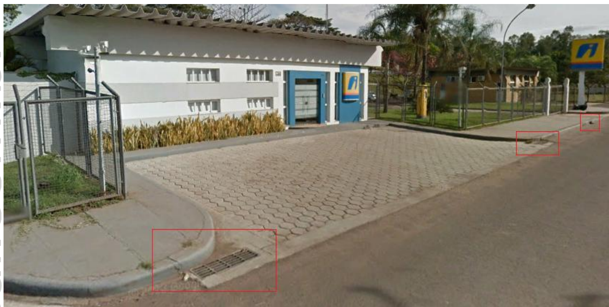
Figura 27: Bocas de lobo existentes na Rua Antônio de Carvalho Lage Filho. Fonte: Master Ambiental (2013).
