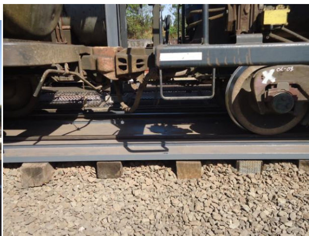
Figura 14. Bandejas instaladas nos trilhos dos vagões.
