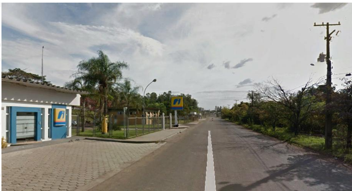
Figura 25: Vista geral da pavimentação do entorno do empreendimento.
