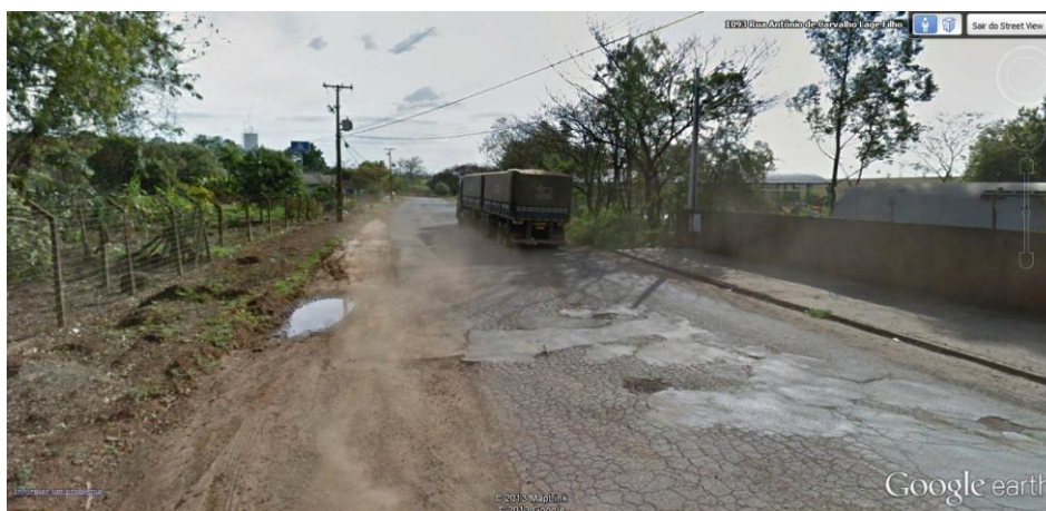
Figura 42. Via com buracos entre o empreendimento e a Rodovia Celso Garcia Cid.
