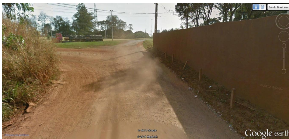
Figura 43. Trecho não pavimentado da Rua Antônio de Carvalho Lage Filho, próximo ao acesso da Rodovia Celso Garcia Cid
