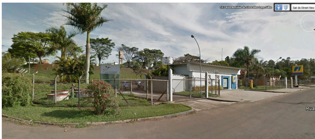
Figura 22. Acesso do POOL IPIRANGA
