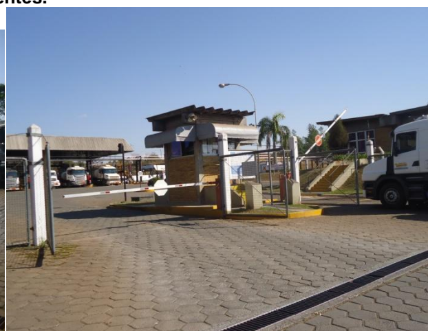
Figura 30: Área permeável do empreendimento, (guardia) – detalhe para o piso recoberto por paver.
