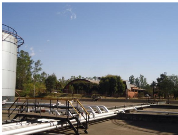
Figura 4. Vista do local onde serão implantados os novos tanques.
