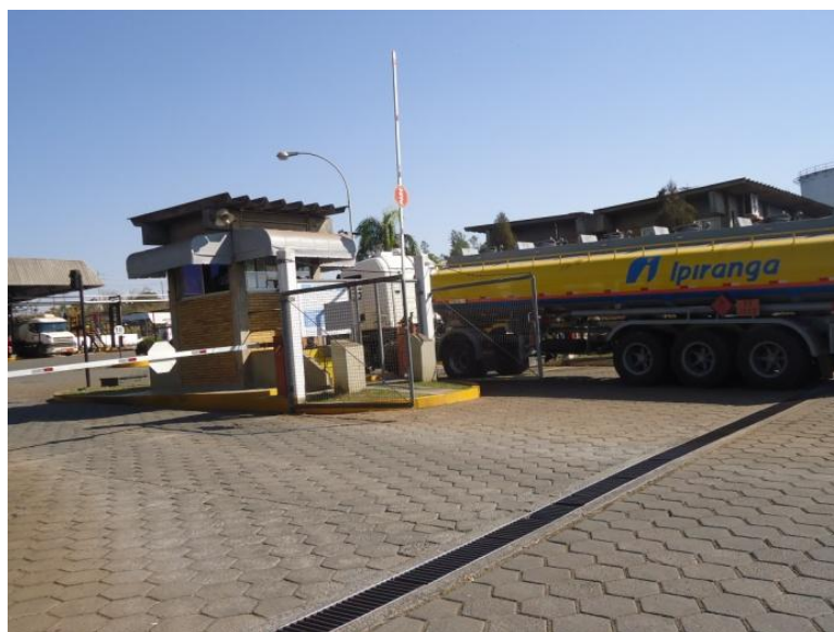
Figura 57. Guarita de controle de acesso ao Pool.
