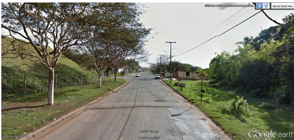
Figura 41. Buracos na via e lombada apenas com sinalização vertical, pouco antes do empreendimento.
