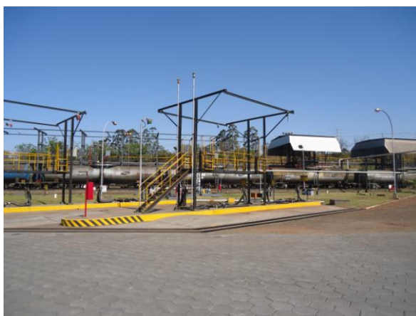
Figura 6. Plataforma de descarga de Hidrocarbonetos recebidos por caminhão tanque.
