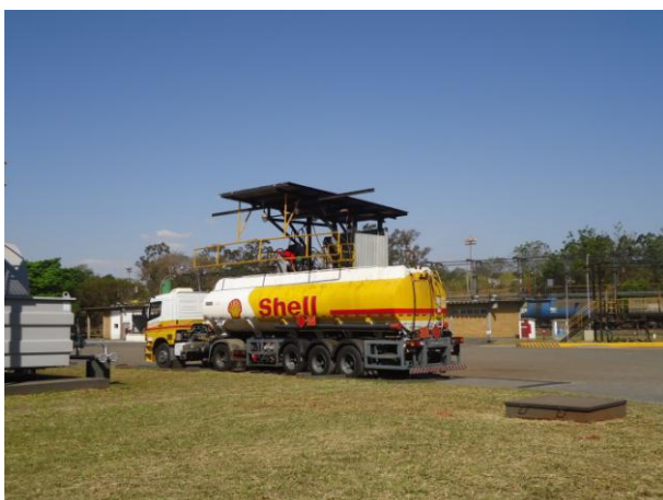
Figura 7. Plataforma de Aditivação e descarga de Diesel S-10.
