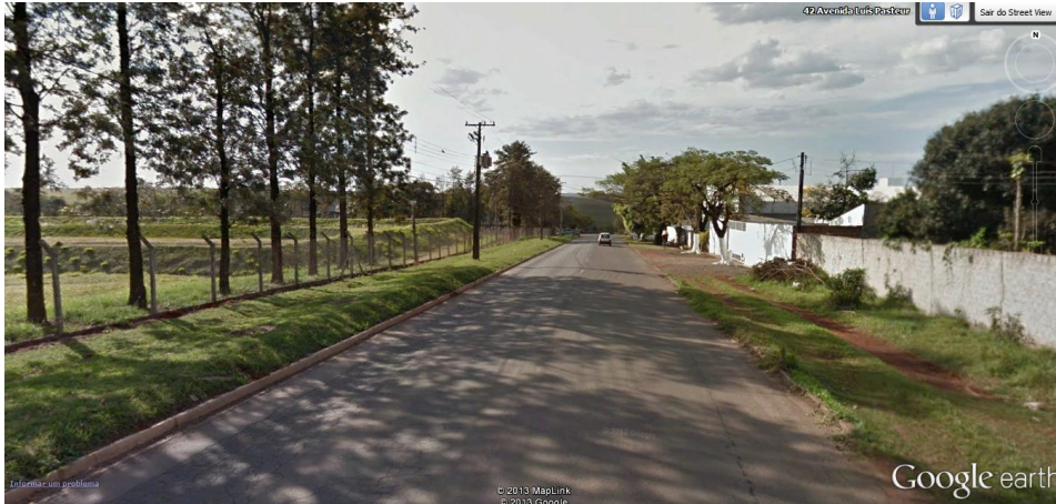
Figura 40. Via com asfalto trilhado pelos caminhões, sem sinalização.
