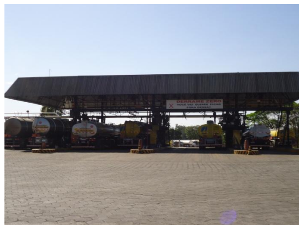
Figura 8. Vista das lajes de abastecimento / descarregamento.
