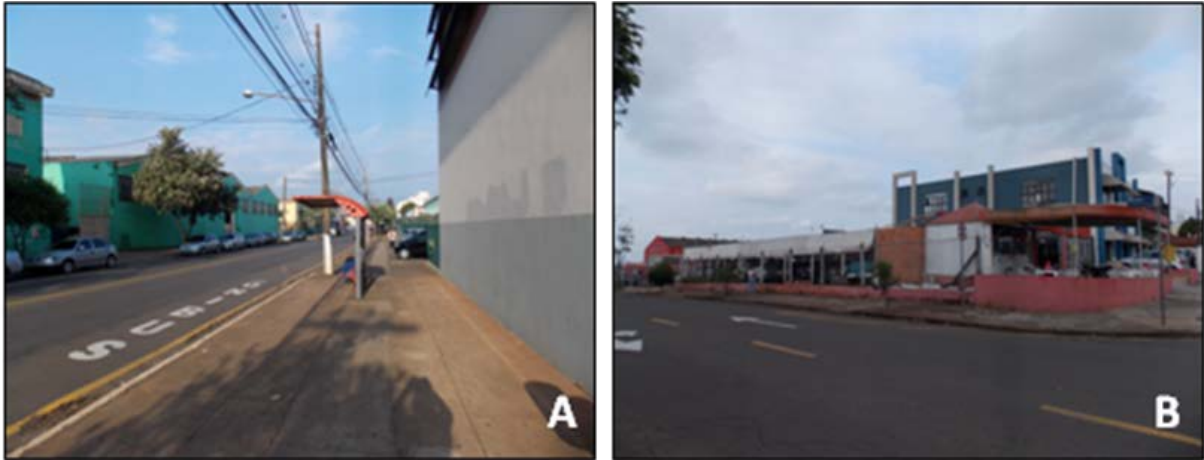
Figura 16: Condições físicas da via principal de acesso ao estabelecimento.
