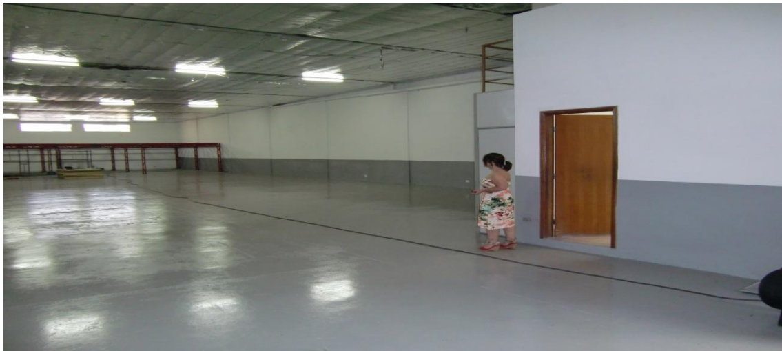
Porta de entrada da sala de espera.
