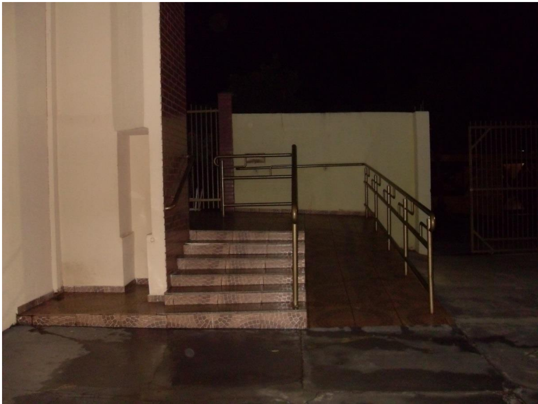
Figura 6: Escada e rampa de acesso no estacionamento.
