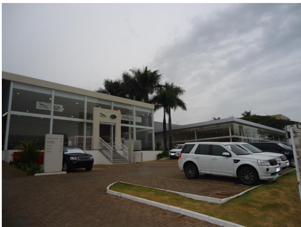
Figura 2: Acesso e vista geral atual do empreendimento. Fonte: Master Ambiental, 2013.
