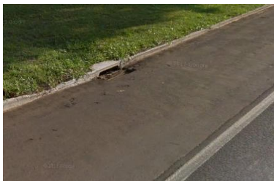
Figura 21: Vista de bueiro instalado na Avenida Tiradentes.
