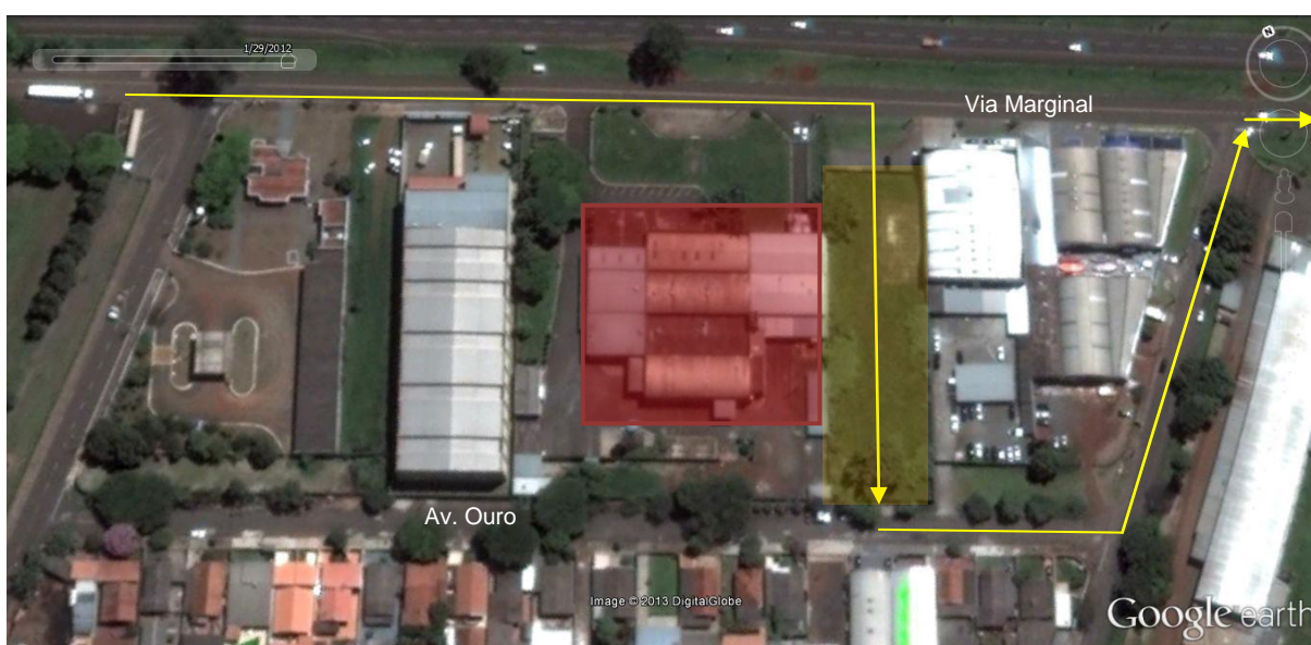
Figura 50. Empreendimento e lote vago ao lago onde ocorre o descarregamento dos veículos usados e sugere-se que descarregue também os novos seguindo a rota indicada. Fonte: Master Ambiental, 2013.
