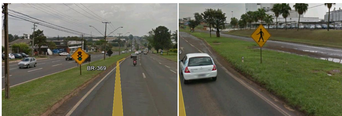
Figura 33: Vista da Avenida Tiradentes (BR-369) e sua sinalização vertical de advertência. Fonte: Google Street View (2012).
