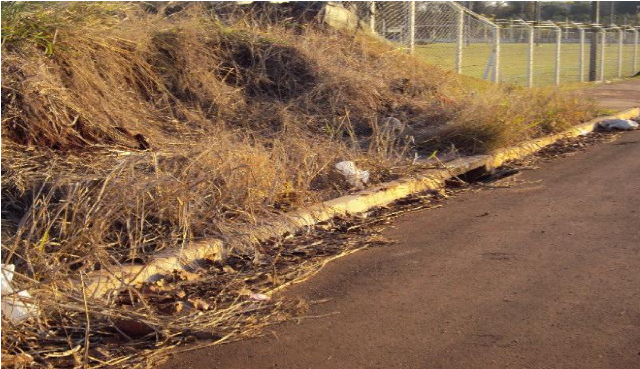
Foto 07: Sistema de drenagem urbana Rua Ulrico Zuinglio, em frente ao lote.
