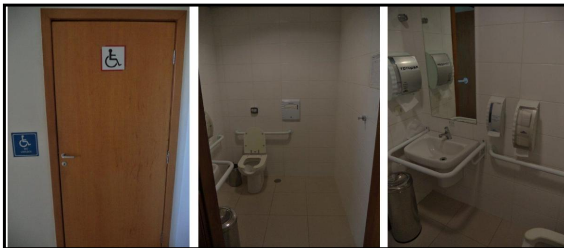
Figura 09: Banheiro para deficientes físicos.
