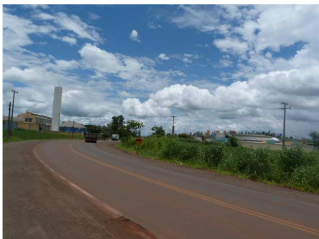
Imagem 5: Vista sentido leste da Rodovia João Alves da Rocha Loures.
