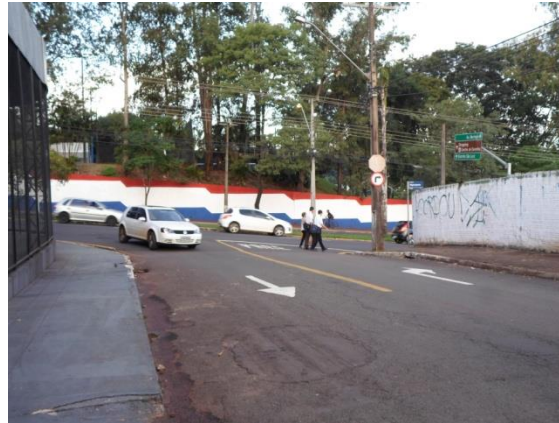
Figura 2 Condições da sinalização vertical e horizontal
