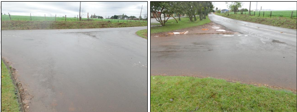
Figura 20: Via de acesso ao empreendimento sem sinalização.
