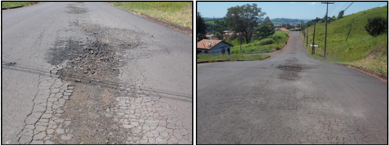
Figura 22: Via estrutural secundária: Rua Elisa Michelete Vecente. Fonte: Brasil Ambiental, 2013.
